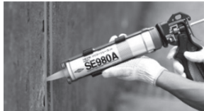
[그림 19] 실리콘 sealant 시공 예
